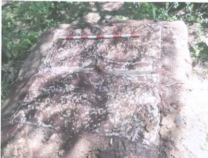
Foto 3 – Cobertura do poço de visita MP2 com lajes calcárias.
