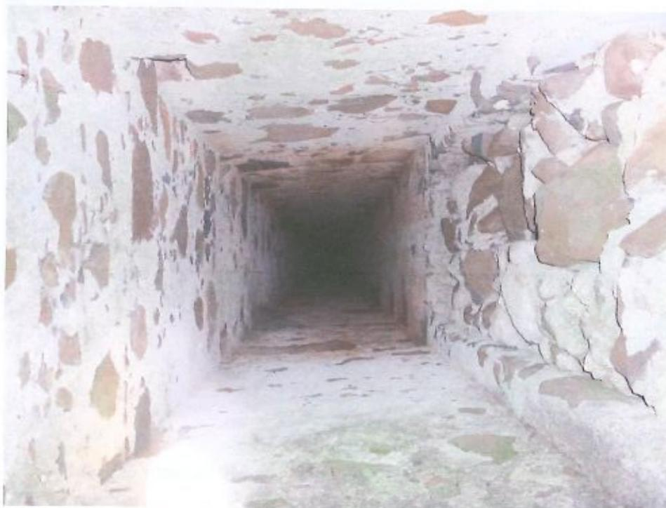
Foto 10 – Aspecto do interior do respiradouro/poço de visita MP4, observando-se no lado direito a porta entaipada. Foto tirada a partir da abertura na cobertura.
