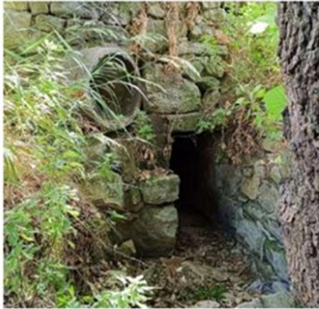
Foto 01 - Aspeto da obra de descarga pluvial e aqueduto
