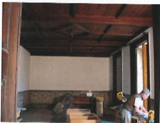
72. Salão do primeiro piso. A decoração interior não faz uso dos motivos decorativos mouriscos utilizados no exterior do imóvel (05.11.2014).
