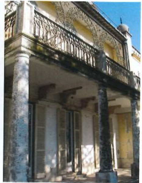
13. Vista da varanda, piso térreo e colunas (05.11.2014).
