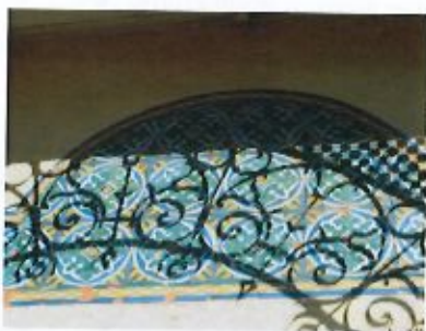
27. Registo de azulejos padronizados sobre a verga das janelas do primeiro piso do corpo central (05.11.2014).
