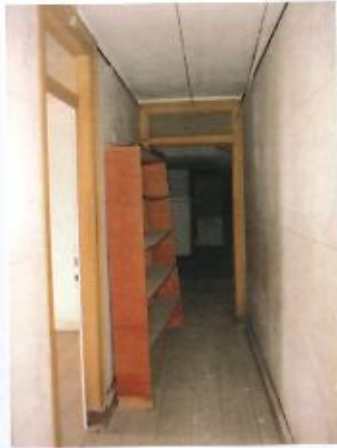
63. Corredor central de acesso às divisões do sótão (05.11.2014).
