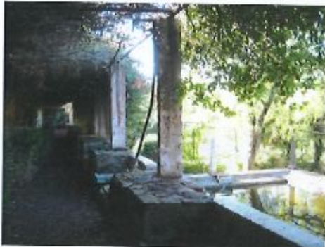
43. Área coberta por latada e trepadeiras, junto ao tanque de irrigação (05.11.2014).
