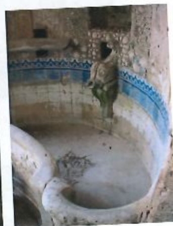
39. Bacia da fonte em cantaria revestida no seu interior por um alizar de azulejos brancos com friso azul (05.11.2014).
