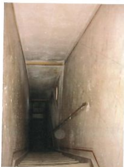
59. Escada de acesso ao sótão (05.11.2014).
