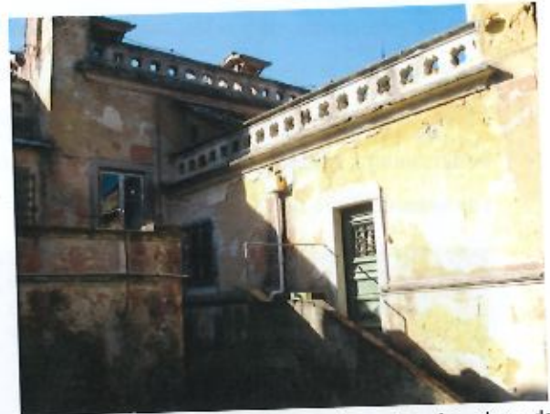
31. Vista parcial da fachada posterior antes das obras de recuperação (05.11.2014).
