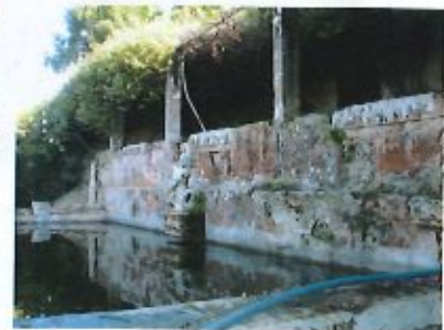
48. Vista do tanque de irrigação para rega e refresco existente na quinta (05.11.2014).
