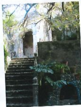
41. Fonte e escadaria de acesso à casa de fresco (05.11.2014).
