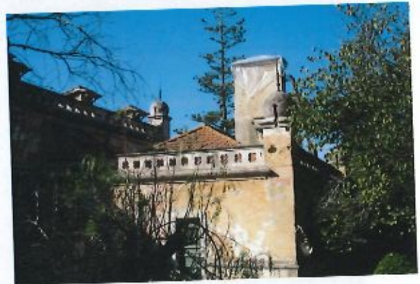
33. Vista parcial do corpo adossado à fachada posterior antes das obras de recuperação (05.11.2014).
