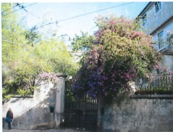
10. Muro e portão de entrada em ferro com motivos decorativos idênticos à guarda do muro da propriedade (5.11.2014).
