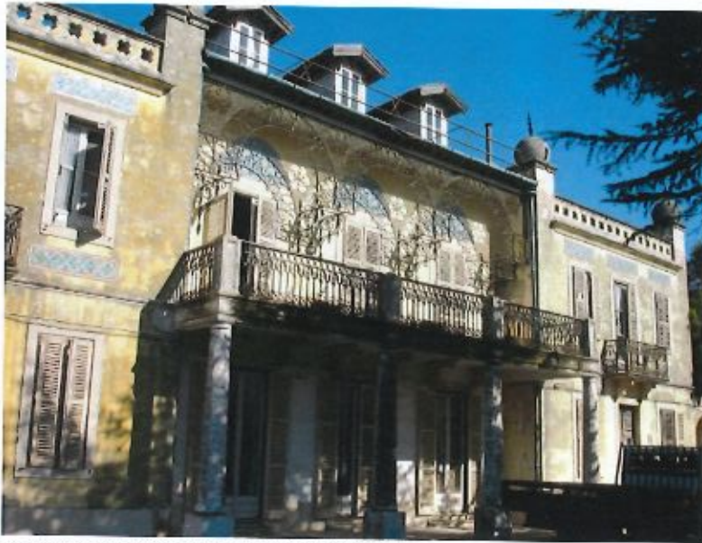
12. Corpo central da fachada principal (05.11.2014).
