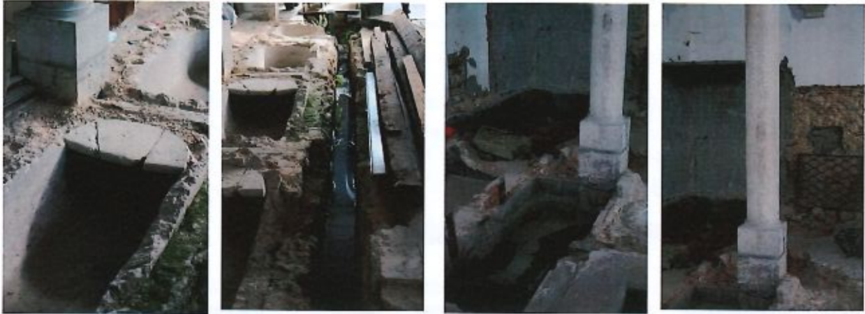
Figs. 35 a 38. Pormenor das banheiras. PM, 4.11.2021.
