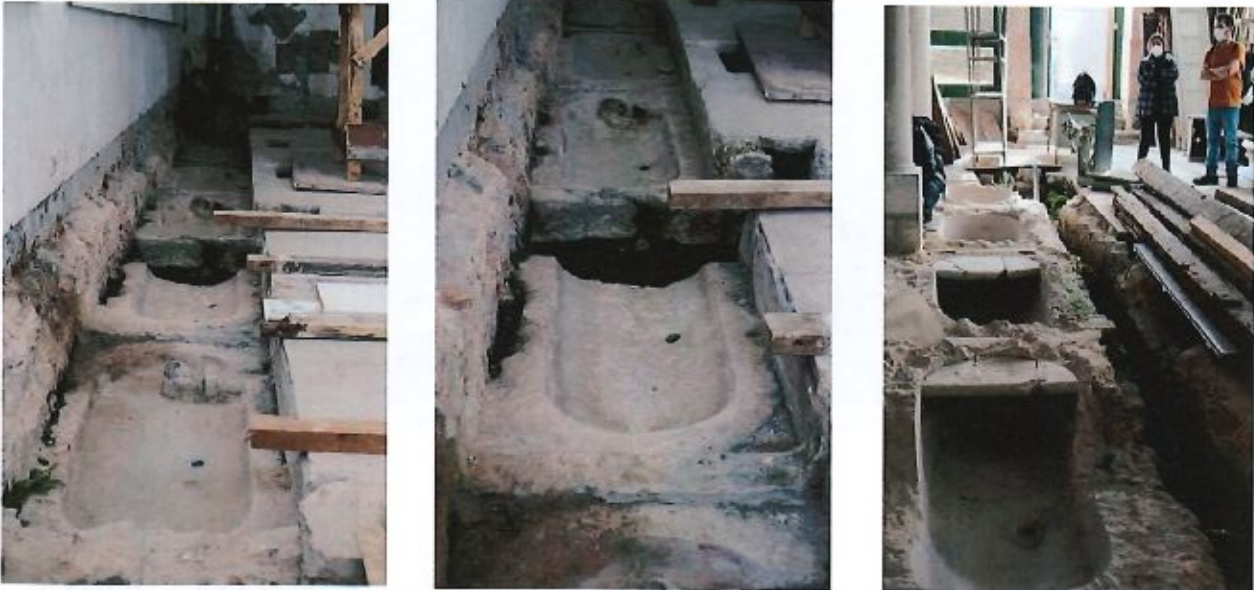
Figs. 50 a 52. Vista para diversas ordens de banheiras das antigas Alcaçarias do Duque. PM, 4.11.2021.
