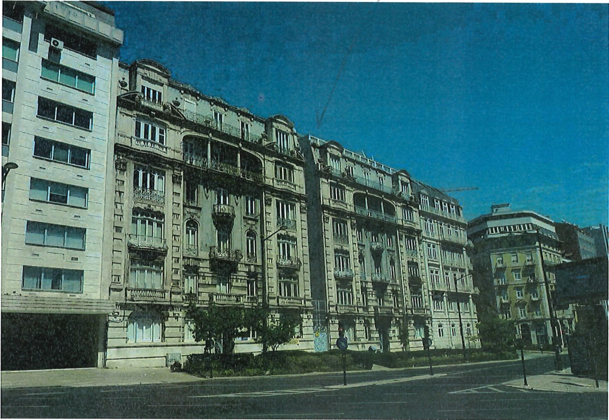
FIGURA 3 – Vista dos edifícios gémeos da Rua Braamcamp, 84 e 86-88, em Lisboa (julho de 2020).
