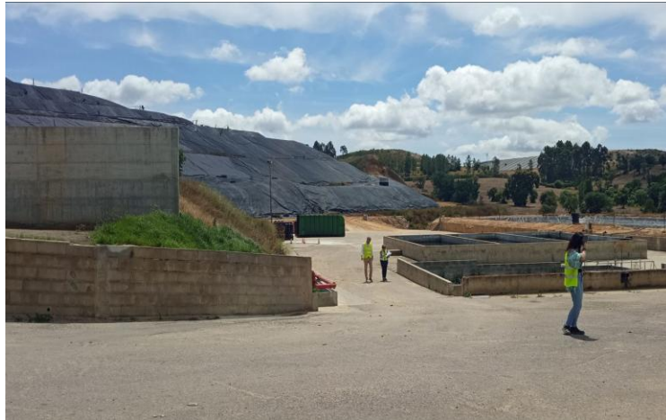
Foto 3 – Acumulação de lixiviados – canal de águas pluviais localizado na base do talude da Lagoa 4 (hexagonal) – visita em 09/05/2023
