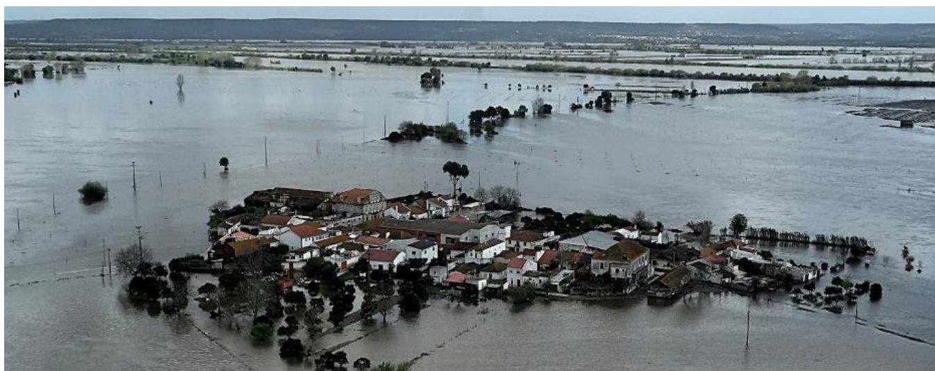
Figura 21 –Inundações provocadas pela Subida repentina das águas
