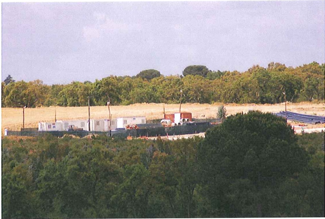
Foto 2 - evidências de atividades de construção
