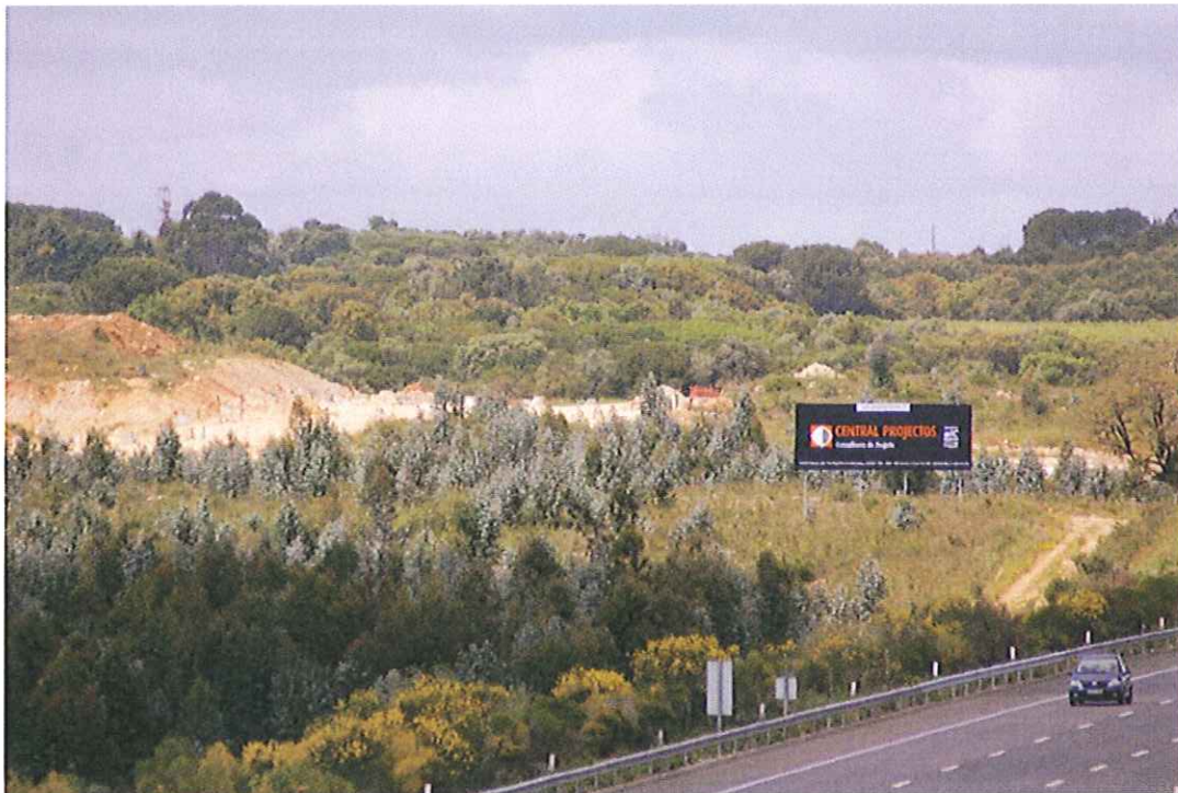
Foto 1 - evidências de atividades de construção
