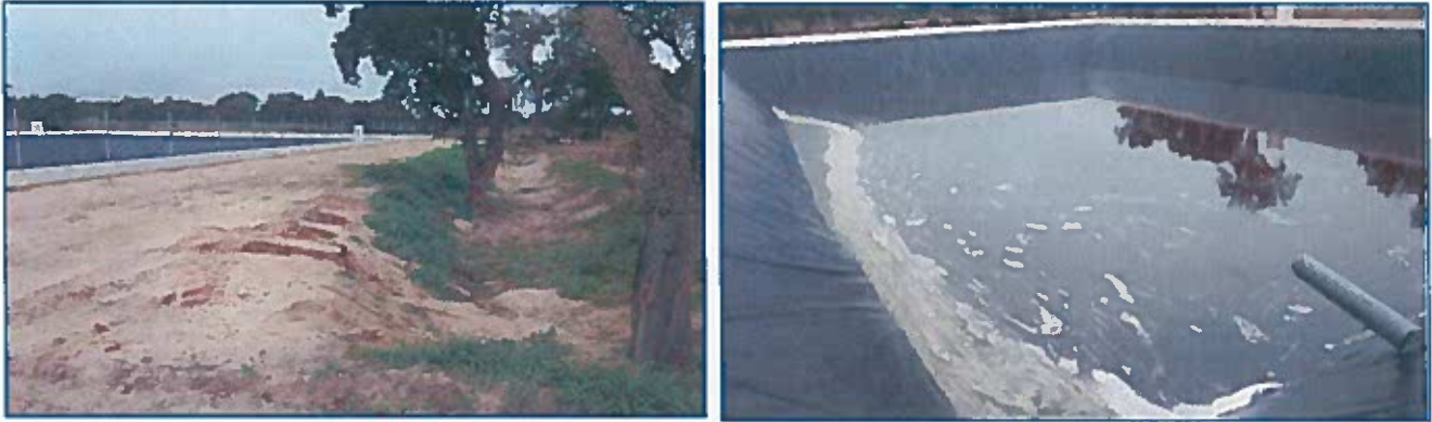
Figura 4 – Nova lagoa de retenção de efluentes (Imagem a 31/01/2019)
