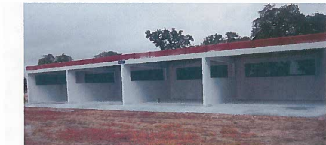
Figura 7 – Necrotério para utilização futura
