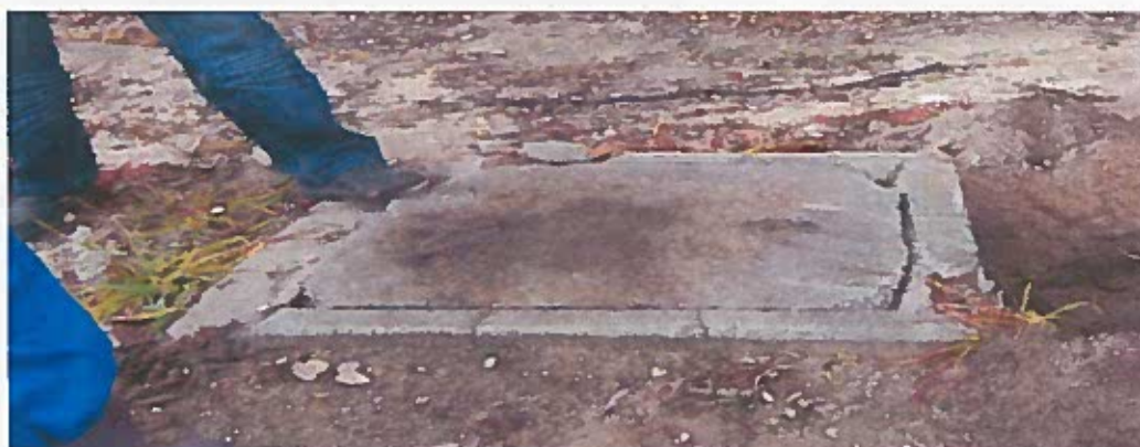
Figura 9 – Fossa associada à habitação
