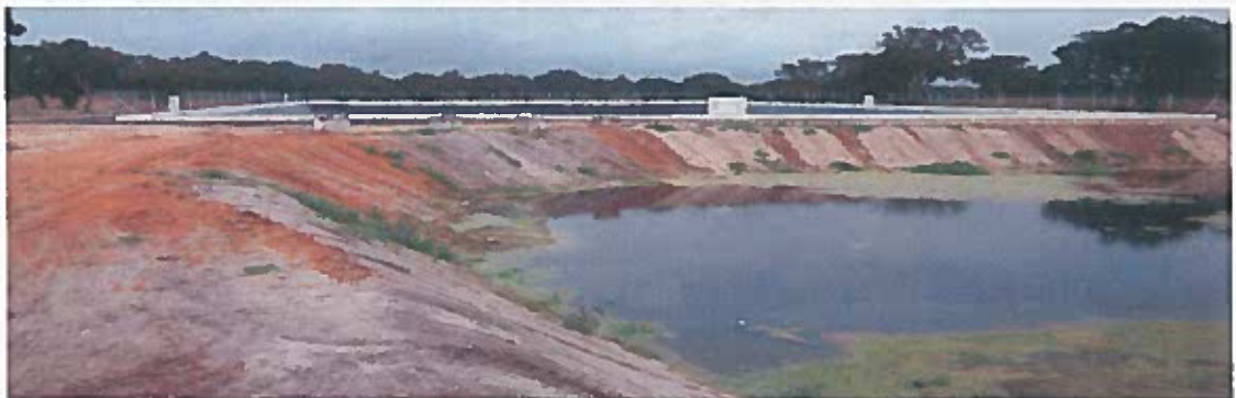
Figura 3 – Lagoa construída e lagoas de retenção desativadas (Imagem a 31/01/2019)
