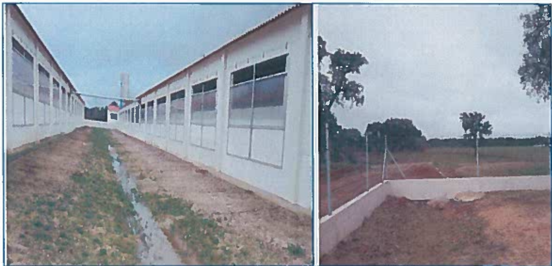
Figura 12 – Drenagem das águas pluviais
