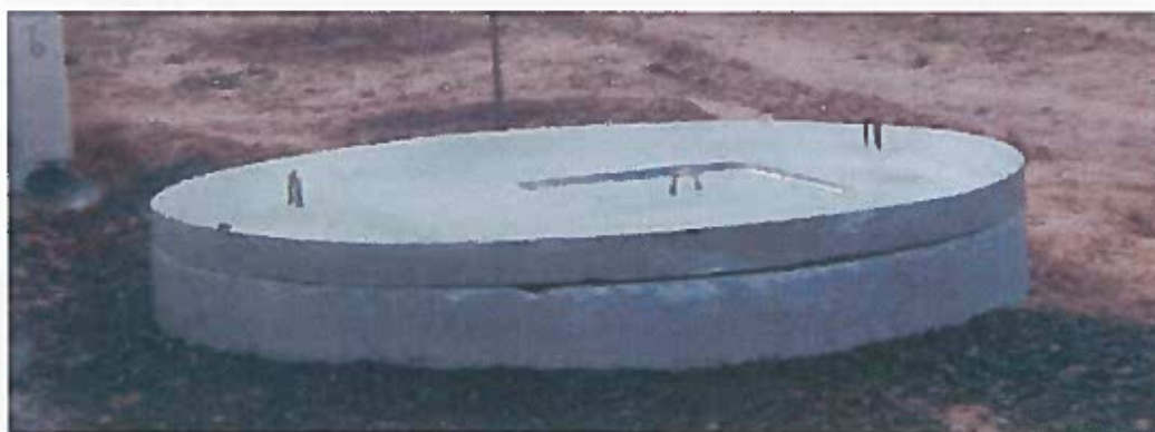
Figura 8 – Fossa associada às instalações sanitárias
