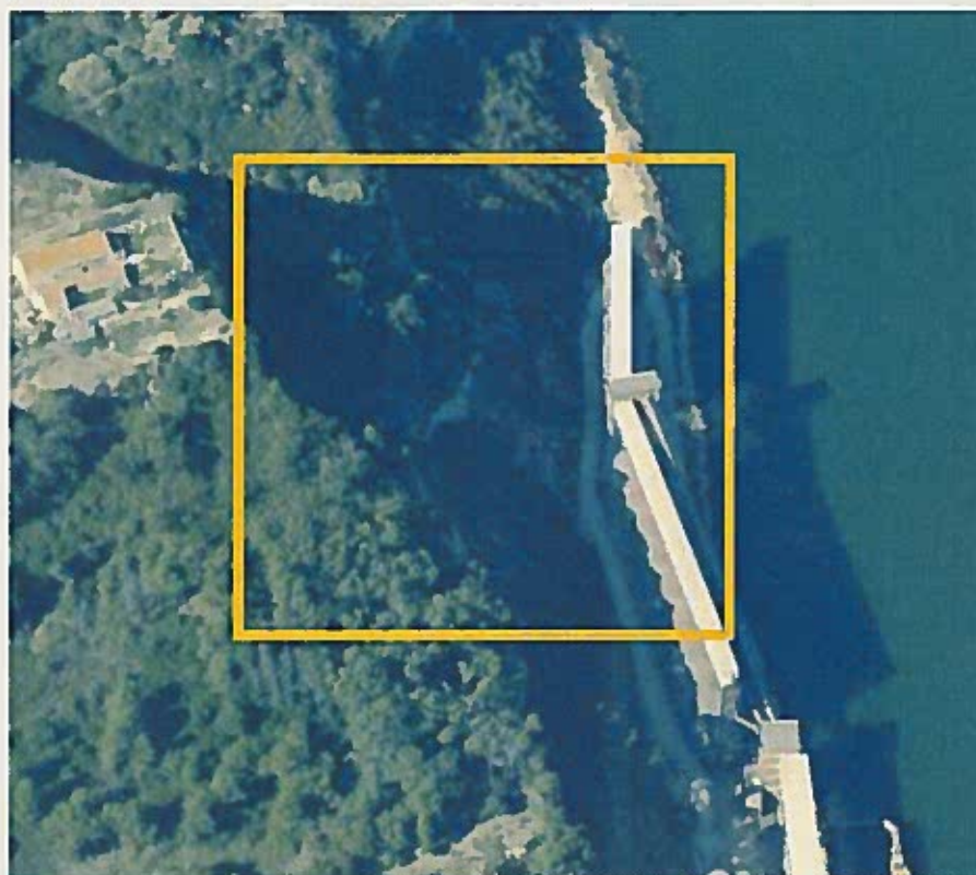
Base da encosta com sinais de instabilidade do terreno.
