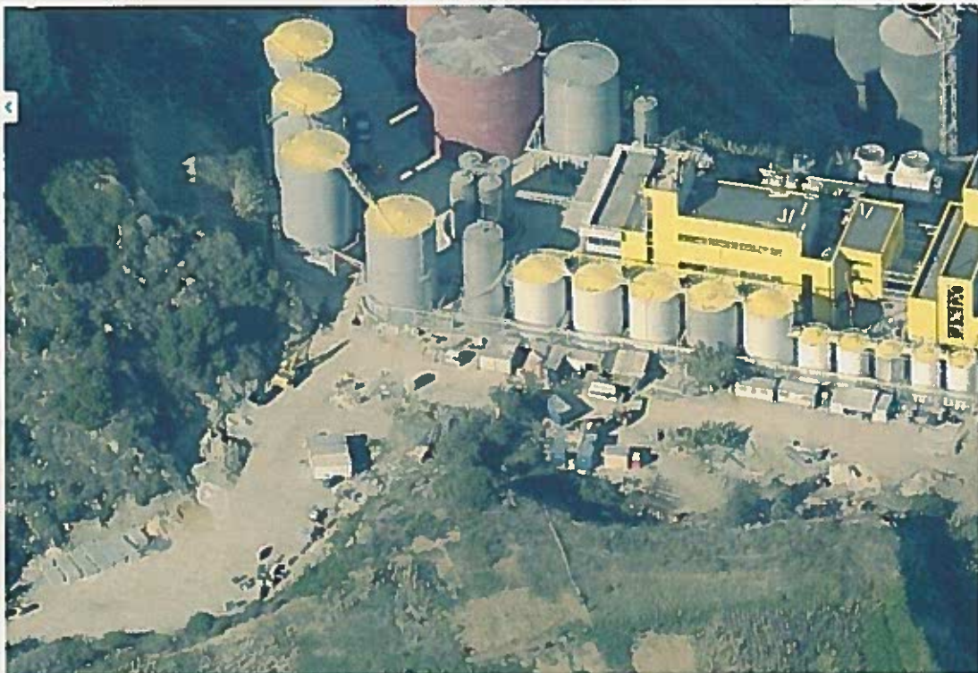
Plataforma adjacente às instalações da Sovena Oilseeds
