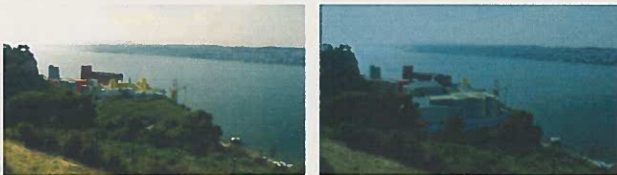
Vista sentido E/O com a localização e implantação do novo projecto SOVENA XXI.
