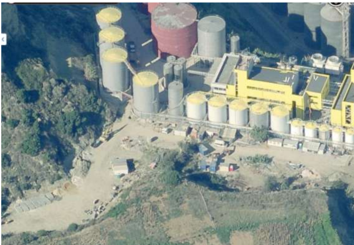
Plataforma adjacente às instalações da Sovena Oilseeds.
