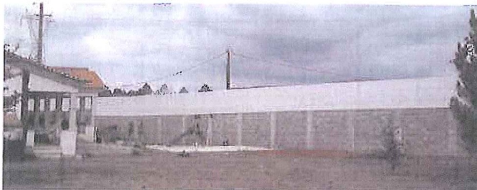
Figura 4: Pedreira com Muros e Painéis resultado da vistoria
