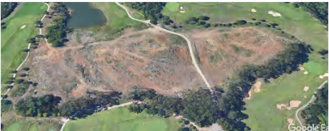
Vista Aerea DEPOIS da intervenção e do Impacto Ambiental:
