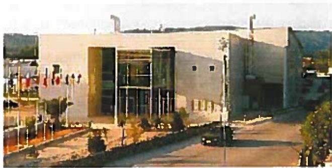
Pavilhão Multiusos - Rio Maior
