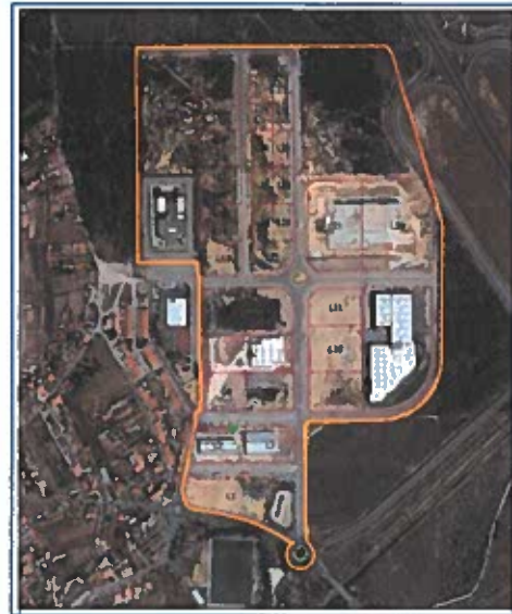
Fig.3 - Extrato de foto aérea com a nova via na área do PP (Fonte: EIA)
