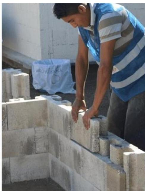
Figuras 10, 11 e 12: Sistemas construtivos com blocos de betão de encaixe.
