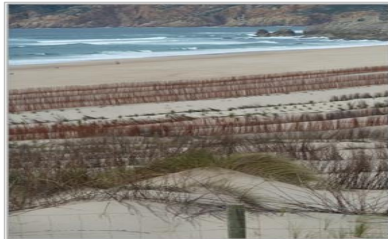
Figura 39 – Estabilização e requalificação do cordão dunar na praia do Guincho
