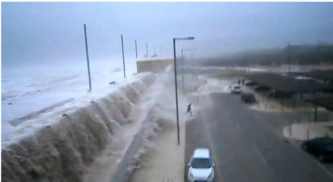
Figura 29 - Galgamentos costeiros. Costa da Caparica, Almada, 2014
